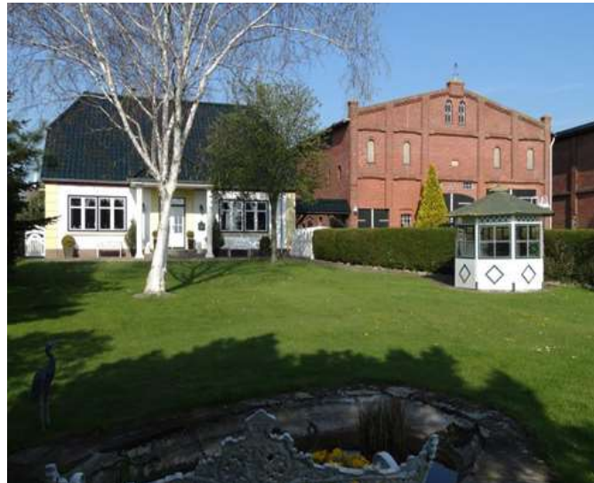
Ostermarkelsdorf 3, Fehmarn, Einfamilienhaus und Scheune
