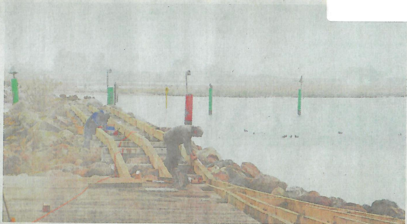
Der Bau der „Hafenterrassen“ hat begonnen. Einheimische und Gäste haben zukünftig auf den geplanten Bänken und dem Sitzpodest einen fantastischen Blick auf die Hafeneinfahrt und den Graswarder. FOTO: RAHLF
