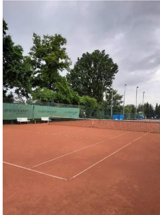
Flutlichtanlage TC-RW Havighorst Quelle: Regionalmanagement
