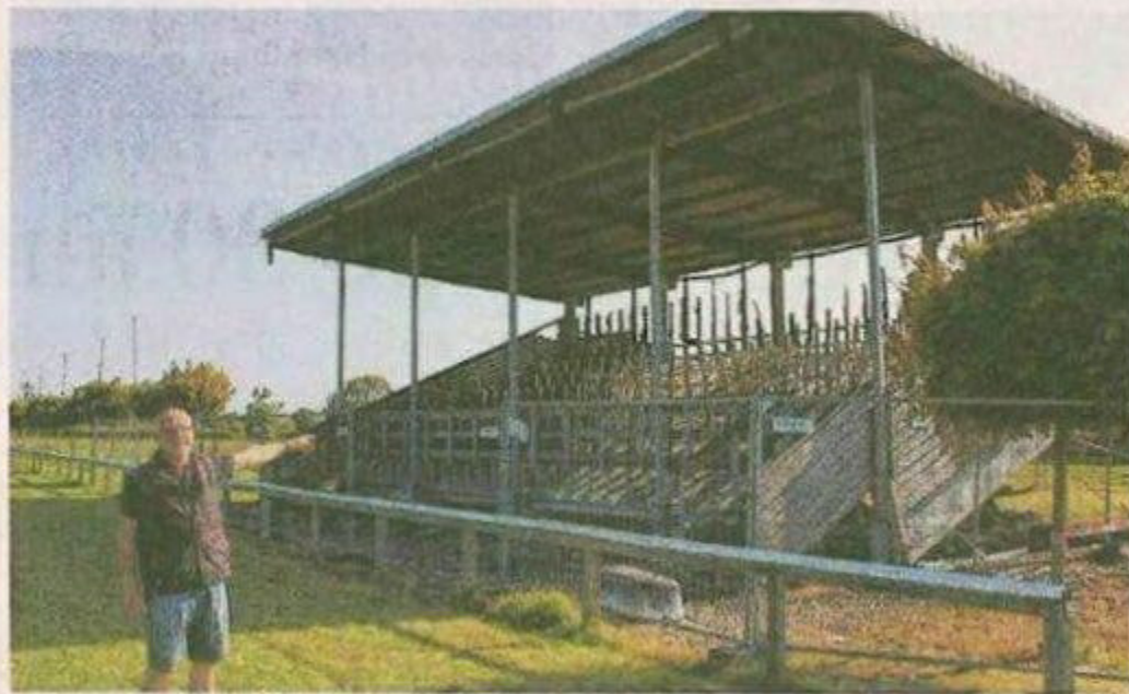
Brandruine Tribüne: Eine Baustelle gibt es für Hinrich Köhlbrandt schon. Das geplante neue Reitsportzentrum erreicht ganz neue Dimensionen. FOTO: GJS
